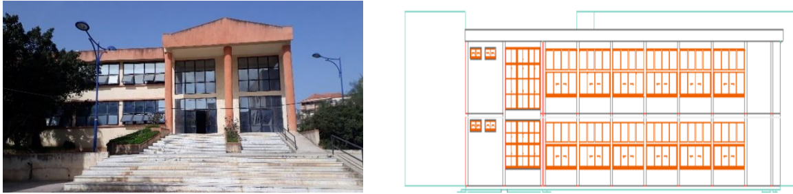
Figure 43: les façades du bloc d'architecture a campus Targa ouzemmour Source : auteur, 2023
