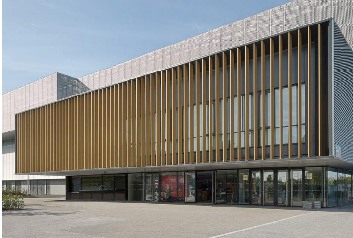
Figure 66: image d'exemple de brise soleil verticale.
