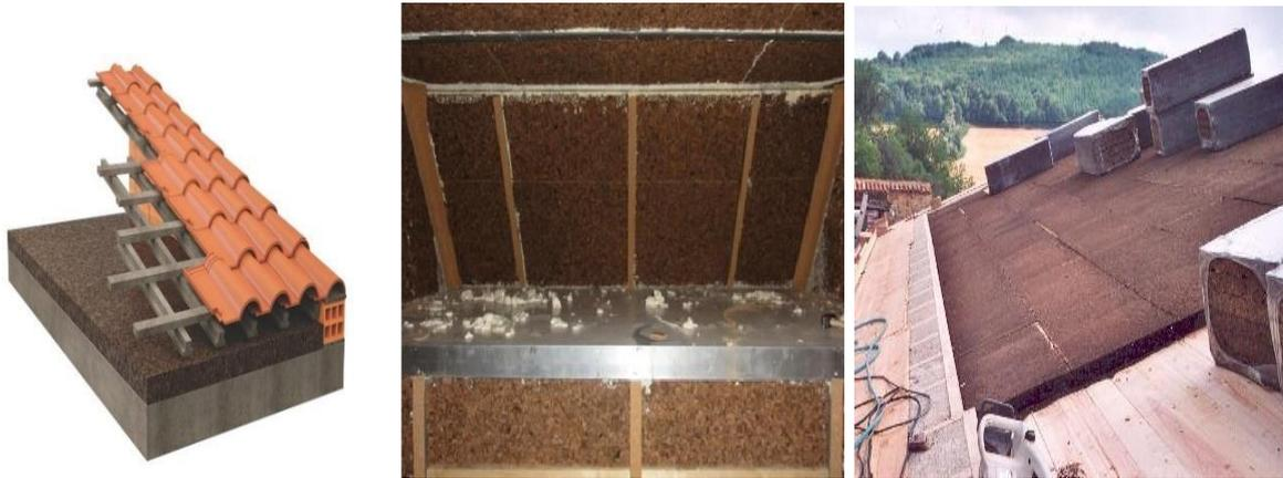
**Figure I.37.** Isolation thermique et phonique de toiture par panneaux de liège [21]
