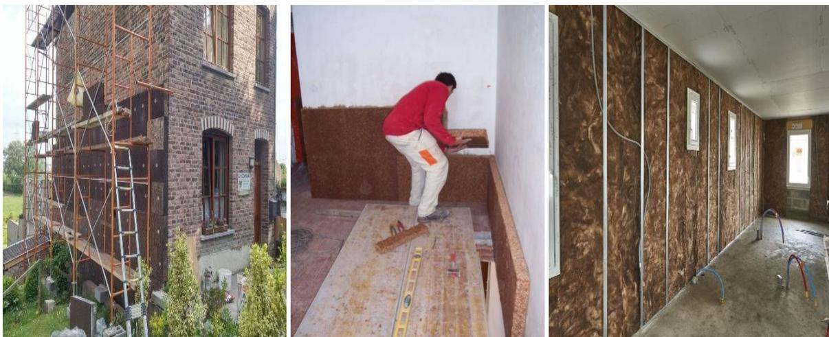
**Figure I.36.** Isolation thermique et phonique en liège de la façade extérieure et intérieure [21]
