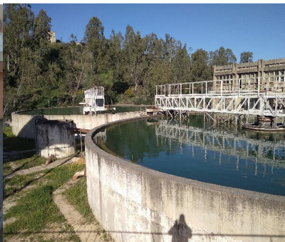
Figure 13: Bassin de décantation
