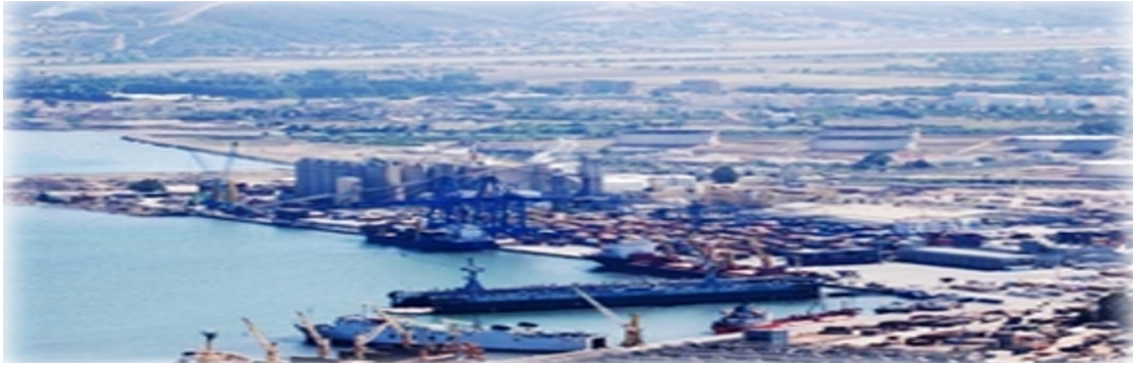
FIGURE 1.3 – Situation géographique de Cevital
