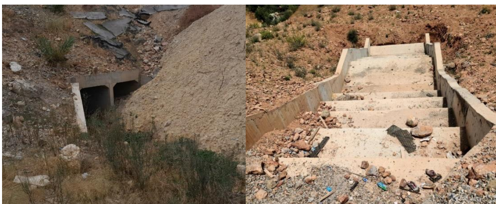
Figure 15 : photo de double canal (à gauche) et canal en escalier (à droite)
