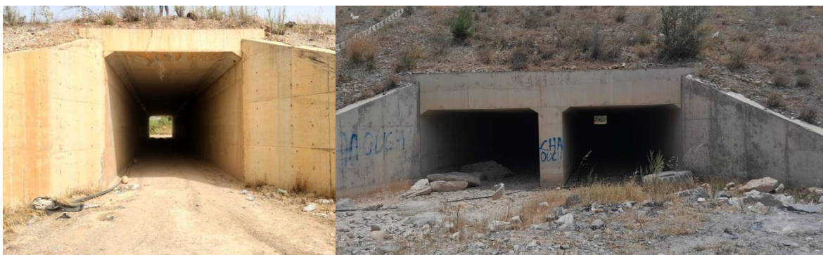
Figure 14 : Photos de tunnel simple (à gauche) et double (à droite) (Prise de vue : IDRI 10 juin 2024)
