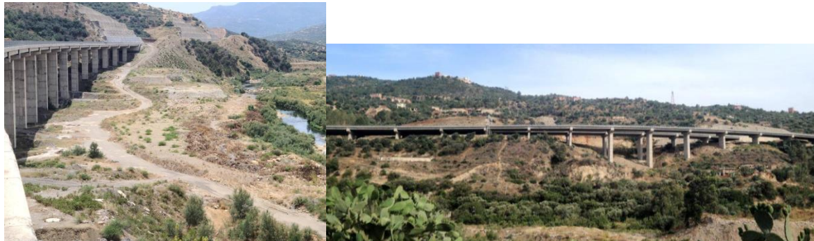
Figure 13 : Photo de deux grands ponts : l'un en aval du tunnel de Sidi Aich (photo gauche), l'autre en amont (photo droite) (prise de vue : DAHMANA 10 juin 2024).
