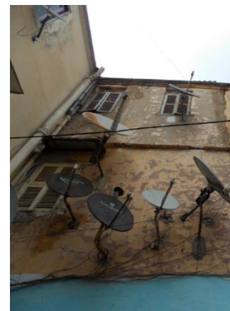
Figure 89 : montrant la façade sud-ouest. Source auteurs, 2017
