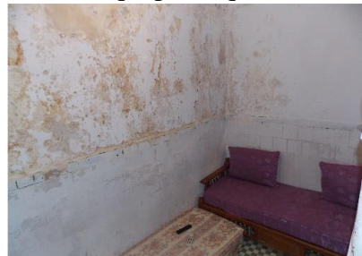
Figure 126 : montrant l'utilisation de la chaux blanche à l'intérieure, source : auteurs, 2017
