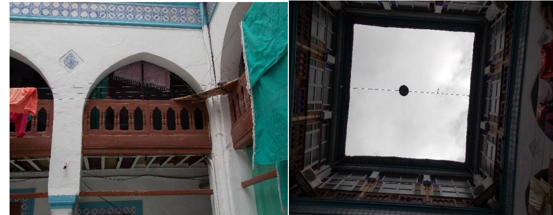
Figure 91 : montrant les balustrades de l'entresol. Source auteurs, 2017
