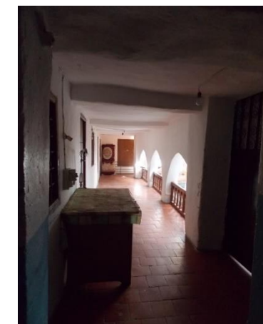
Figure 79 : montrant les poutres en bois, cachées par la maçonnerie, source : auteurs, 2017
