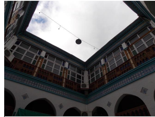
Figure73 : montrant le vitrage au niveau de l'étage, source : auteurs, 2017.
