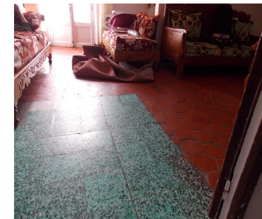
Figure 135 : montrant l'utilisation du carrelage à la place de la tomette rouge, source : auteurs, 2017
