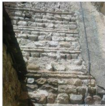
Figure 121 : montrant les matériaux utilisés dans la construction des murs, source : auteurs, 2017
