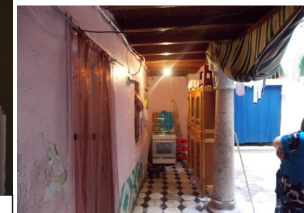
Figure 103 : montrant la cuisine aménagée dans la galerie. Source : Auteurs, 2017.
