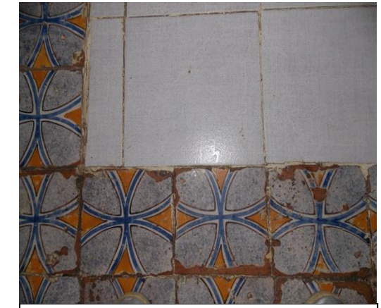
Figure 136 : montrant l'utilisation du carrelage à la place de la mosaïque ancienne, source : auteurs, 2017
