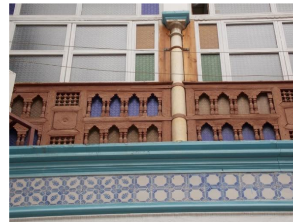
Figure 80 : montrant le type colonne utilisée à l'étage, sources : auteurs, 2017.
