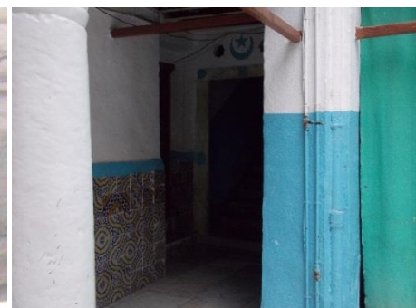
Figure 76 : montrant les tirants en bois. Source : auteurs, 2017
