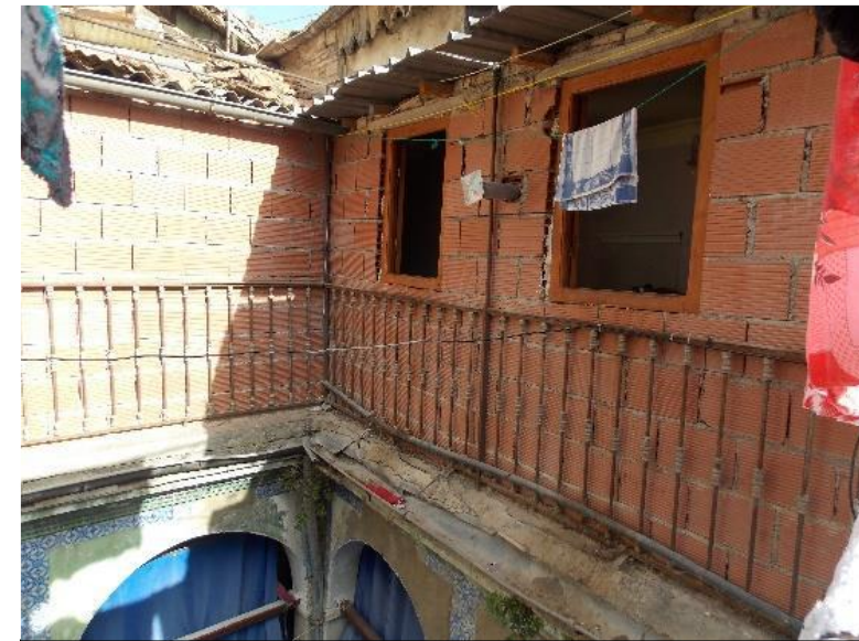
Figure 117: montrant l'étage ajouté au niveau de la terrasse, source : auteurs, 2017
