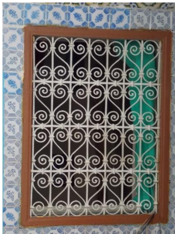
Figure 47 : montrant la fenêtre d'une pièce de taille moyenne
