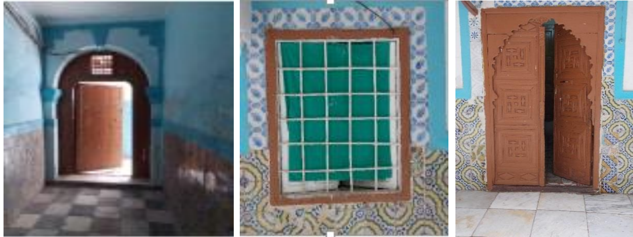
Figure 85 : montrant les différents types d'ouvertures qui n'ont pas été changées,
