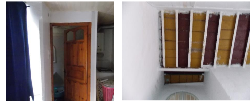
Figure 86 : montrant les planchers actuels. Source auteurs, 2017
