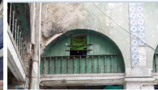
Figure 138 : montrant les modifications au niveau de la galerie de l'entresol, source : auteurs, 2017
