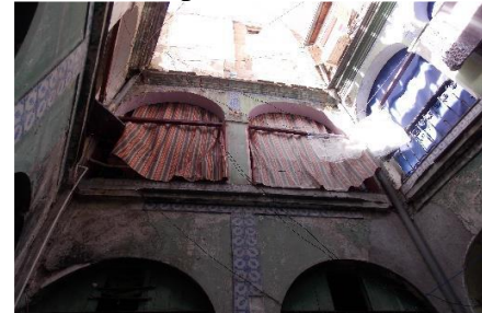
Figure 127 : montrant l'utilisation de la chaux et nila verte à l'extérieure, source : auteurs, 2017
