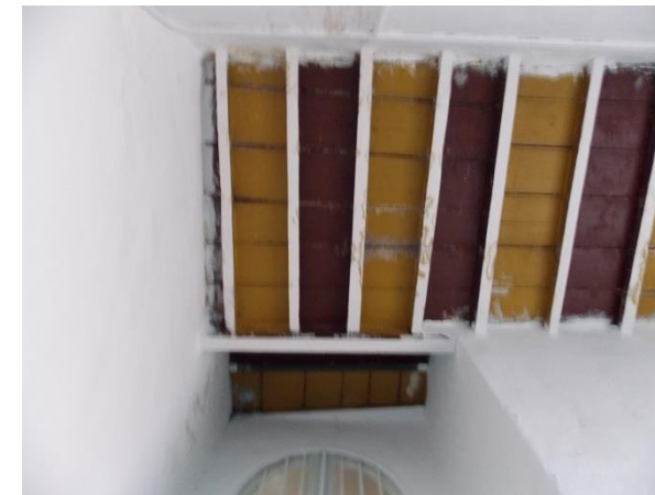
Figure 78 : montrant le plancher en madrier. Source : auteurs, 2017
