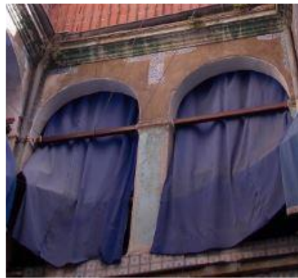
Figure 115 : montrant les tirants en bois, source : auteurs, 2017.
