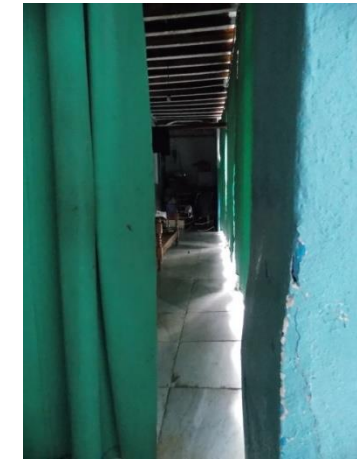
Figure74 : montrant la fermeture des galeries avec des rideaux épais. Source : auteurs 2017.
