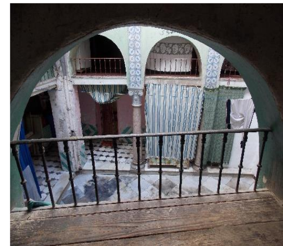
Figure 131 : montrant les balustrades en ferronnerie qui ont remplacé celles en bois, source : auteurs, 2017
