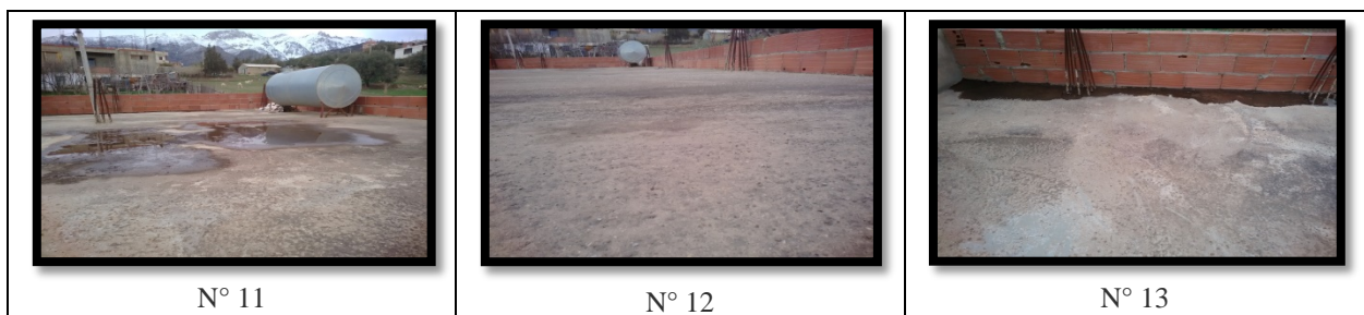
Figure 68 : Terrasse accessible non étanche (infiltration des eaux pluviales). Source : Auteurs.
