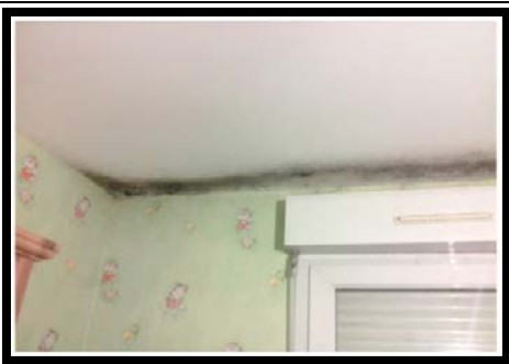
Figure 19 : Moisissures sur le pont thermique d'un plancher. Source : RénoVACT.
