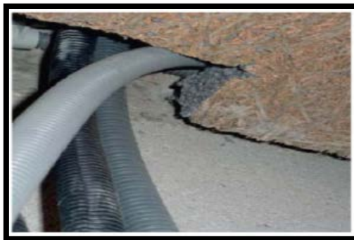
Figure 82 : Coupure d'isolation pour passage de réseau. Source : RénoVACT.
