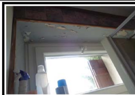
Figure 20 : Dégradations des revêtements. Source : RénoVACT.
