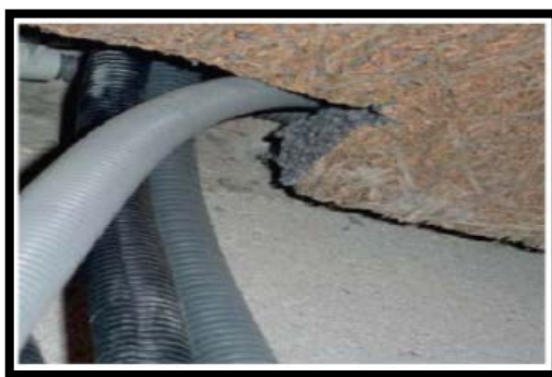
Figure 40 : Coupure d'isolation pour passage de réseau. Source : RénoVACT.
