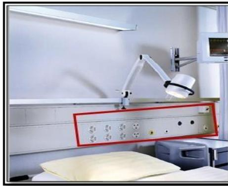
Figure 30 : Gaine d'approvisionnement pour le branchement aux media et l'éclairage. (Derungs.2012.p16).
