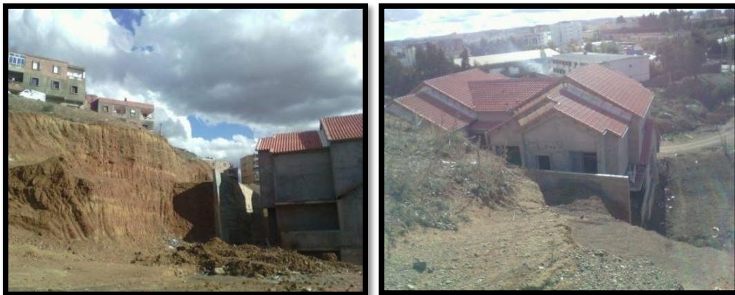
Figure 48 et 49 : Image qui représente le mur de soutènement réalisé. (Auteurs, 2016)
