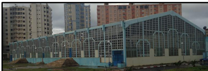
Figure : 2.20. Vue sur la salle de la piscine olympique. Source : Auteurs 2017
