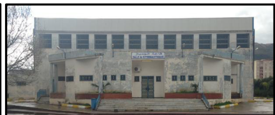
Figure :2.21. Vue sur la salle du gymnase source : Auteurs 2017
