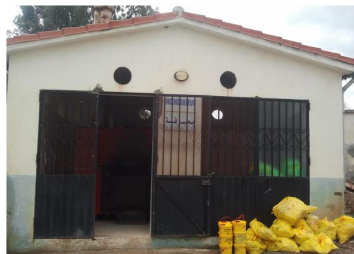
Figure IV.3 : Incinérateur de l'hôpital Source : (Auteur, 2017)
