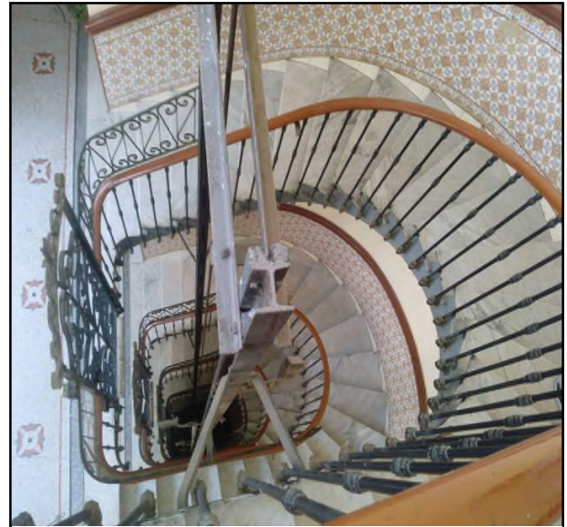
Figure 14 : Escaliers de l'immeuble (31 marches). Source Auteurs. Année 2017.
