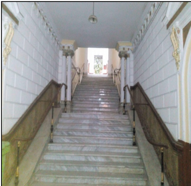
Figure 11 : Escaliers de l'entrée de l'immeuble (31 marches). Source Auteurs. Année 2017.
