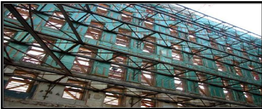
**Figure 86:** exemple de la poutre treillis
