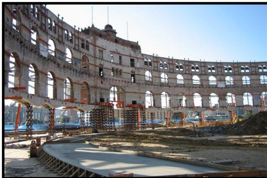
Figure 50: démolition de l'intérieure des arènes source Source : Pierre Engel
