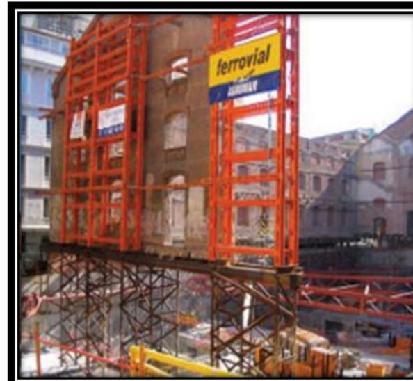
Figure 32: le maintien des murs de brique et travaux de soutènement
