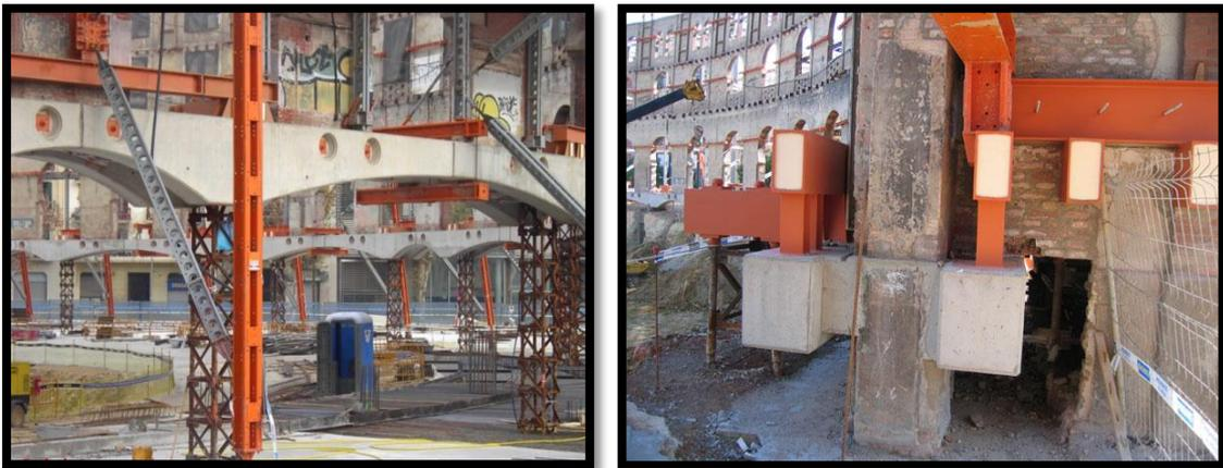
**Figure 39:**étaieiment de la façade et construction d'une ceinture périphérique
