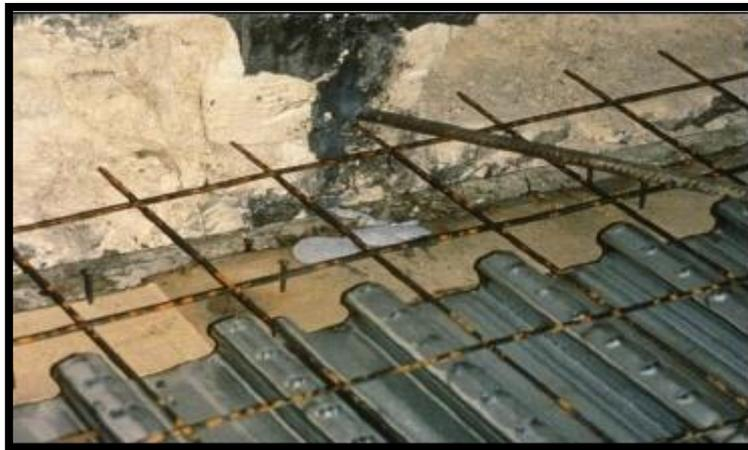
**Figure 98:**exemple des cas d'accrochage sur un mur existants
