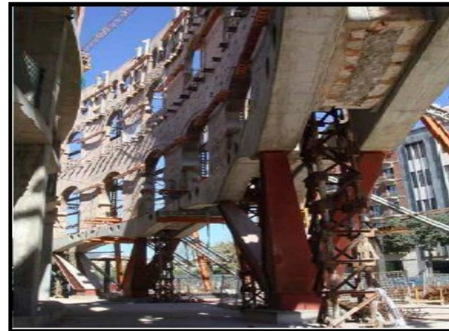
Figure 18:mise en place des poteaux boomerang
