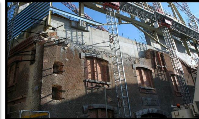
Figure 36: la restauration des façades par leur consolidation, protection et rejointoiement
