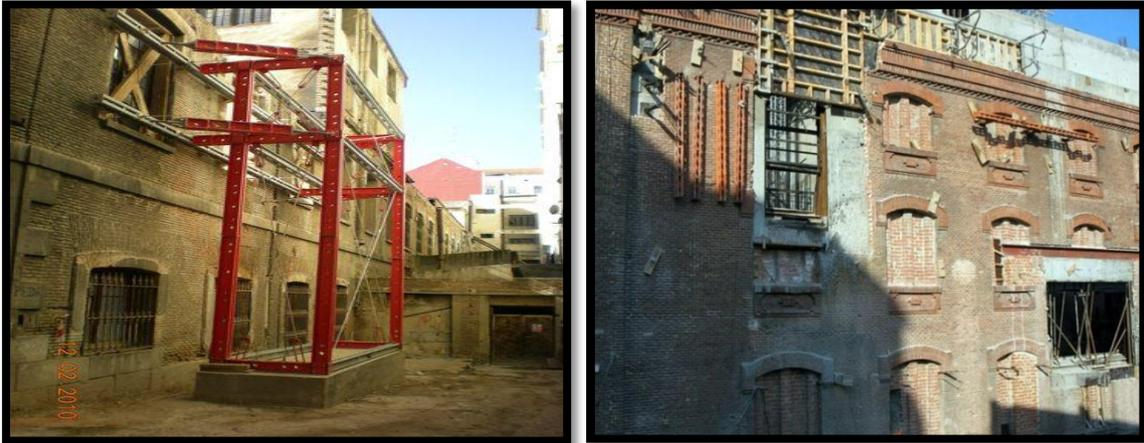
Figure 46:étaielement et consolidation de la façade par des portiques en acier
