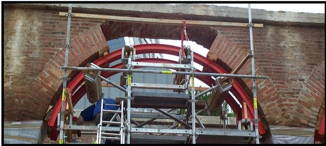
**Figure 42:**consolidation des ouvertures des arènes
