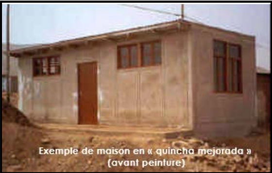
Figure19 : Image d’un exemple de maison en « QUINCHA » (avant peinture).
