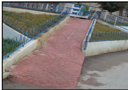
Figure n°92 : Un rampe sans main-courante Source : auteurs, 2016
