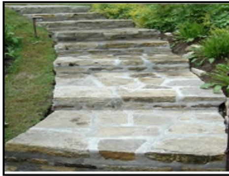
Figure n°30 : escalier maçonné en pierre
