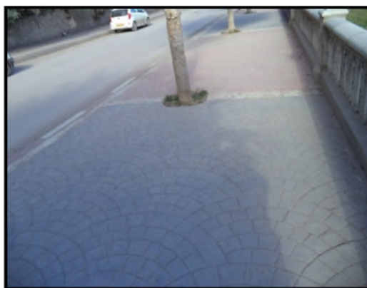
Figure n°88 : un revêtement de type béton Source : auteurs 2016.
