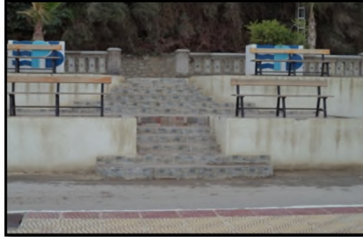
Figure n°91 : Un escalier sans main et avec un revêtement glissant Source : auteurs 2016.
