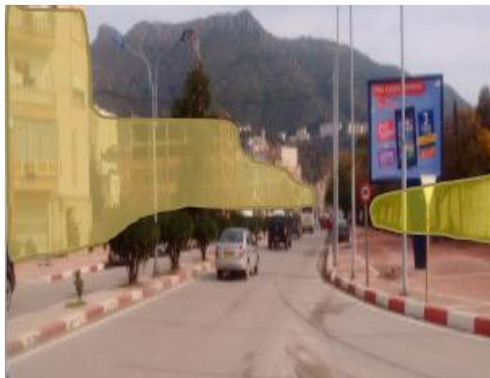
Figure 59 : les parois du boulevard Moulay El Nacer. Source : auteurs 2016.
