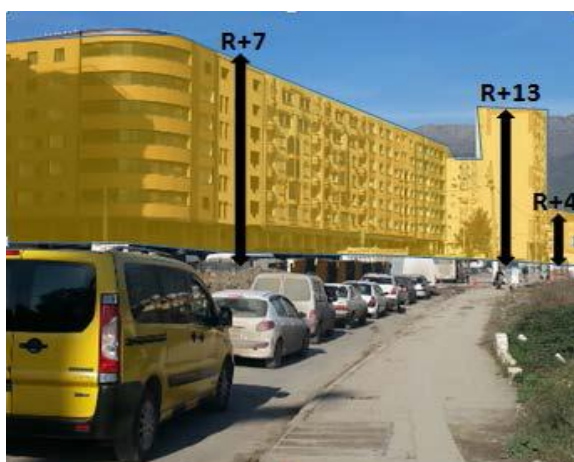
Figure 57 : vue sur la paroi bâtie du Boulevard de la Soummam. Source : auteurs 2017.
