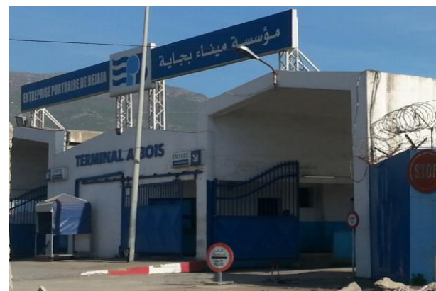
Figure 99 : Terminale à bois. Source : auteurs 2017.
