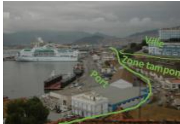
Figure 98 : Zone tampon, vue sur l'écheilliant de l'interface. Source : auteurs 2017.
