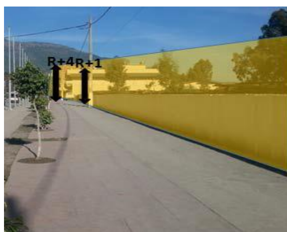
Figure 58 : vue sur la paroi clôturée du Boulevard de la Soummam. Source : auteurs 2017.
