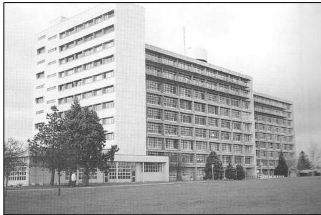
Figure I.10. Pignon ouest et façade sud de l'hôpital, derrière laquelle se trouvent les services d'hospitalisation Hôpital
