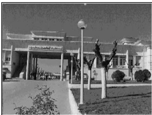
FigureIII.2. Vue sur le pavillon initial sur CHU
