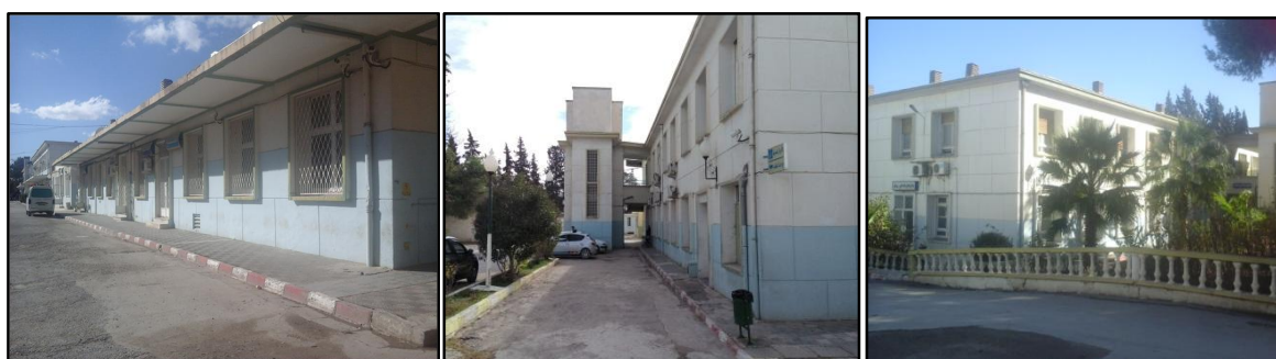
Figure III.22. Vue sur la cuisine et Figure III.23. Vue sur le service Figure III.24. Vue sur médecine La buanderie d'orthopédie interne Source : (Auteur, 2017) Source :(Auteur, 2017) Source :(Auteur, 2017)
