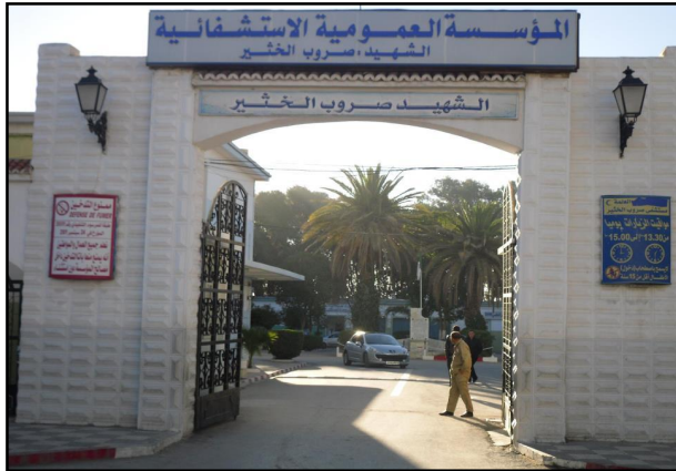
Figure III.12. Entrée principale de l'EPH El-Eulma
