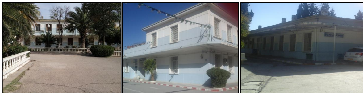
Figure III. 19 : Vue de l'extérieur Figure III.20: Vue sur l'administration Figure III.21: Vue sur le service des Source : Auteur, 2017 Source : Auteur, 2017 maladies infectieuses
