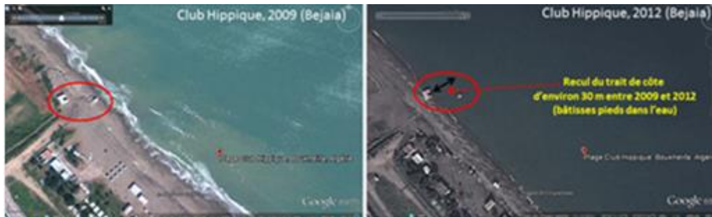
Figure37 : Mise en évidence d'une forte érosion marine au niveau de la commune côtière de Boukhelifa (à côté de l'hôtel les hammadites)
