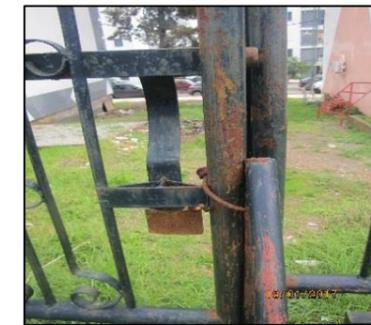
**Fig n°37 : Corrosion de la porte**
