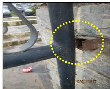
**Fig n°44** : La corrosion des articulations
