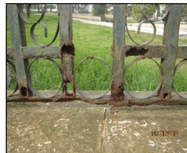
**Fig n°68 :** Corrosion du métal
