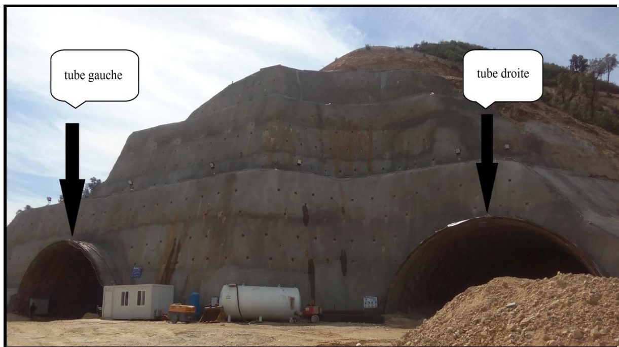
Figure V.1 : les deux tubes de portail d'entrée. [Tunnel de Ait Yahia Moussa]
