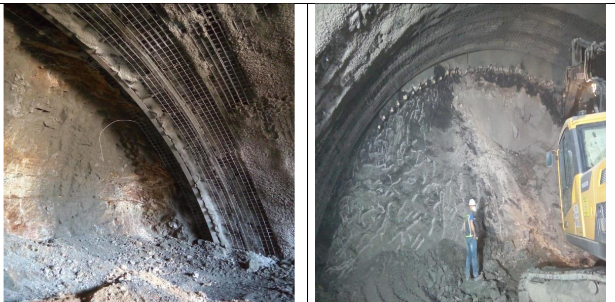
Figure II.9: Pré-soutènement (projet de tunnel d'Ait Yahia Moussa).
