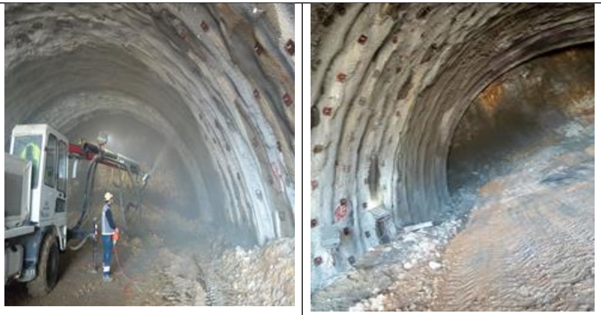
Figure II.10 : Béton projeté (Projet de tunnel d'Ait Yahia Moussa).
