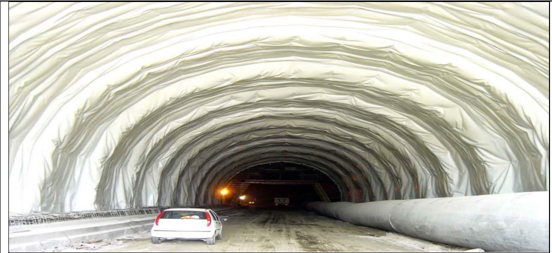
Figure II.15: Pose de l'étanchéité. [18]
