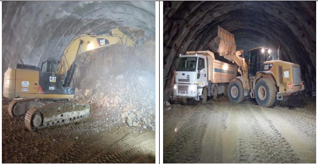
Figure II.8: purge et marinage (Projet de tunnel d'Ait Yahia Moussa).
