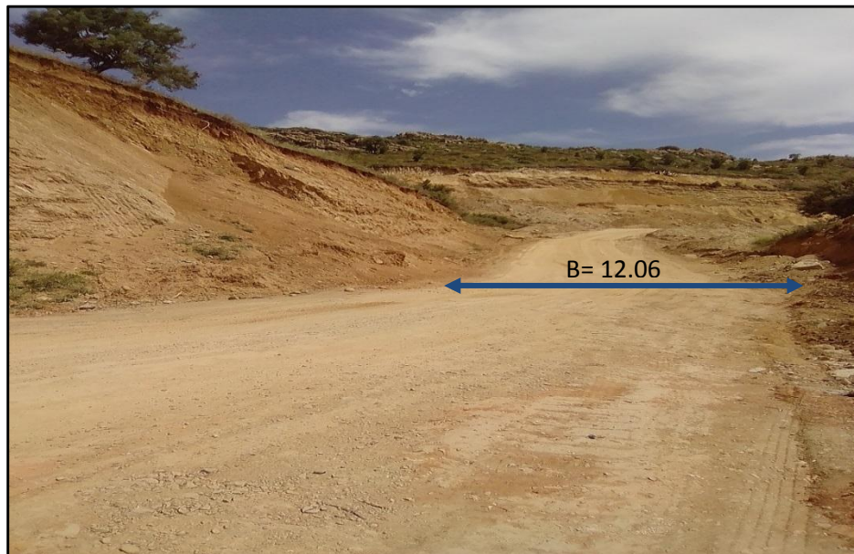
Figure III. 8 : Demi-tranchée d'accès niveau 350 m. (Photo carrière de Djebel Boukhanfer, Mai 2017)
