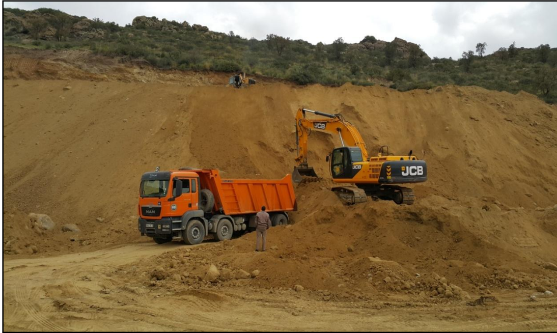
Figure III. 3 : Travaux de découverte de la partie Sud. (Photo Avril2017)
