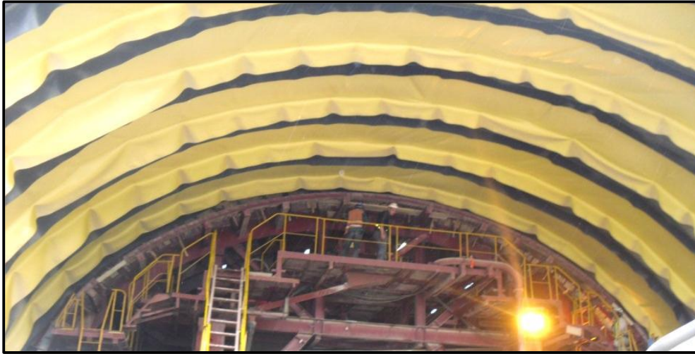
Figure II. 21 : Mise en place du dispositif d'étanchéité.
