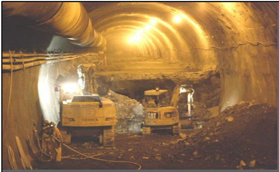
Figure II. 7 : Creusement en demi-section. [23]
