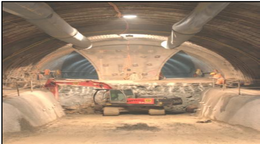
Figure II. 8 : Creusement en section divisée. [23]
