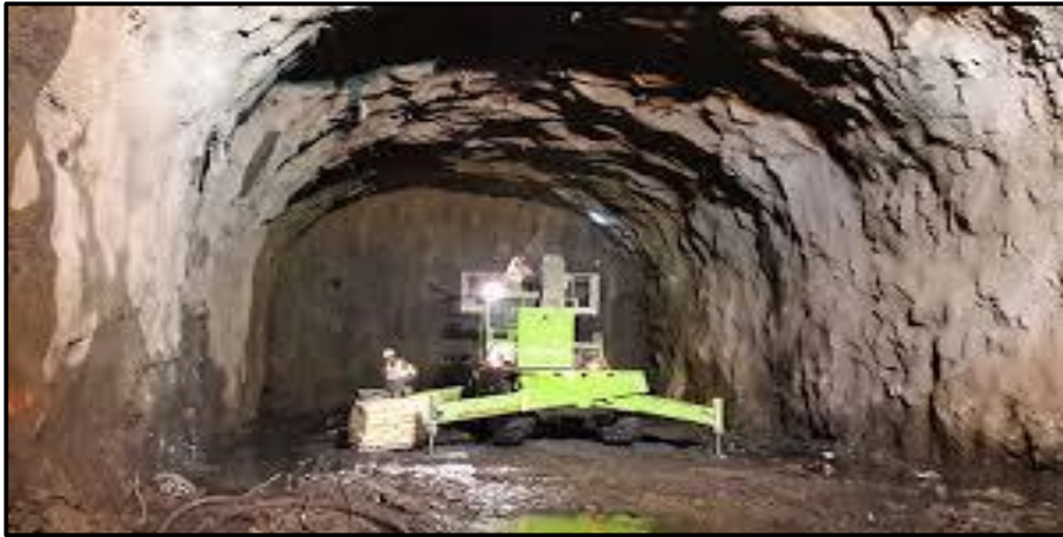
Figure II. 6 : Creusement en pleine section. [23]
