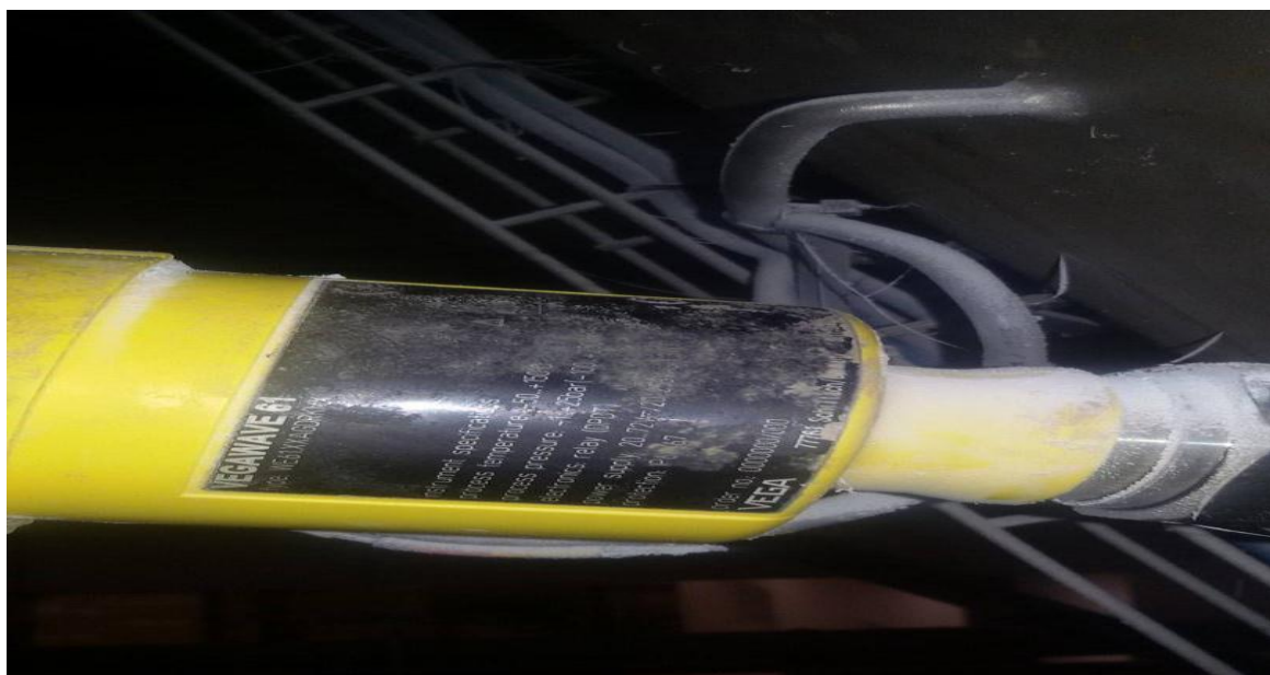
Figure III-5 : Montage d'un capteur de niveau type VEGAWAVE61 sur la trémie de conditionnement de sucre
