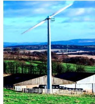
**Figure I.8 :** Éolienne à axe horizontal bipales.
