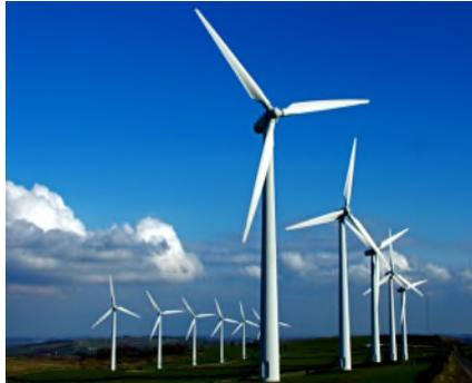
**Figure I.7 :** Éolienne à axe horizontal tripales.
