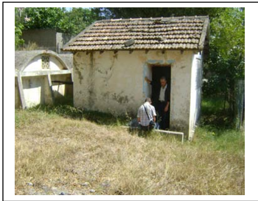
Photo N°17: Vue extérieur de la chambre de vannes du réservoir rectangulaire
