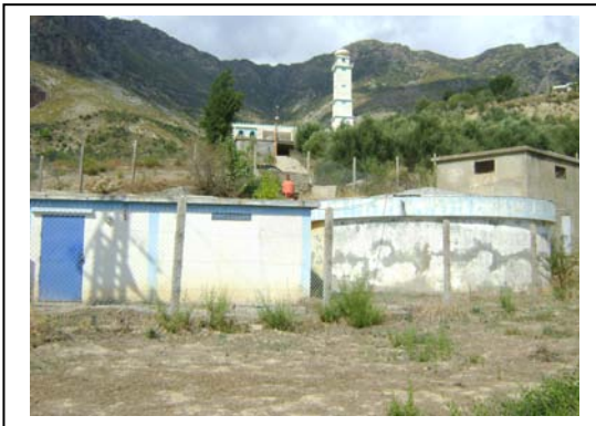
Photo N°21: Vue extérieure des réservoirs de Sidi Abderrahmane
