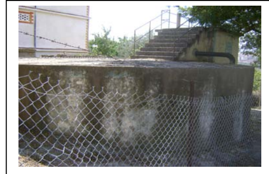
Photo N°16: Vue extérieur du réservoir circulaire (150m 3 )
