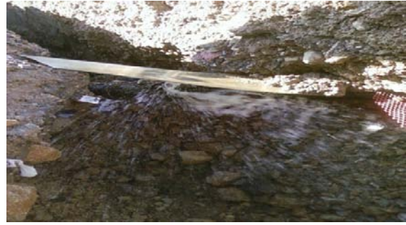
Photos N°38 et 39: Ces photos représentent, quelques exemples sur les fuites existantes sur le réseau.
