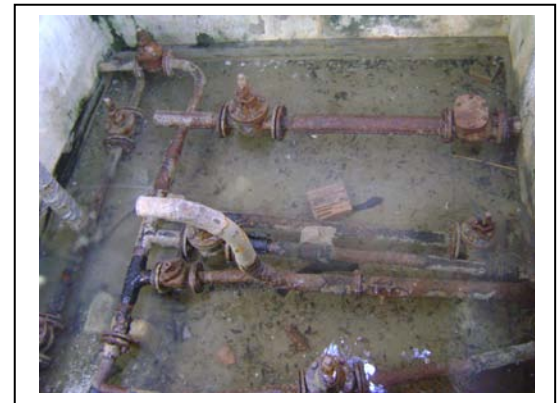
Photo N°20: Vue intérieure de la chambre de vannes du réservoir circulaire
