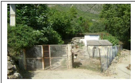
Photo N°03 : Source et station de reprise de Tala Oughanim.
