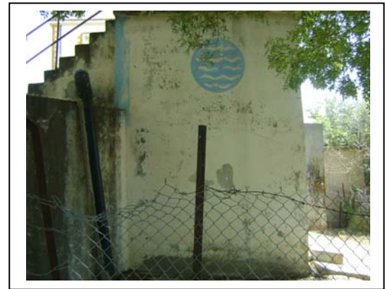
Photo N°18: Vue extérieur de la chambre de vannes du réservoir circulaire
