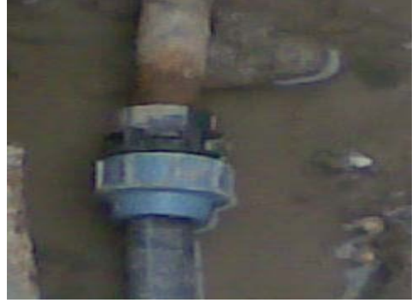
Photos N°44 et N°45 : Ces photos représentent, quelques exemples sur les fuites existantes sur le réseau
