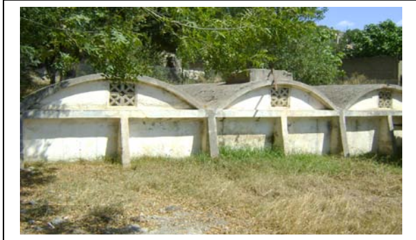
Photo N°15: Vue extérieur du réservoir rectangulaire (250m 3 )
