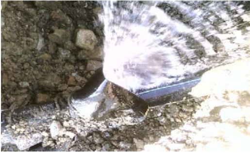
Photos N°38 et 39: Ces photos représentent, quelques exemples sur les fuites existantes sur le réseau.
