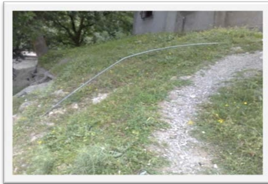
Photos N°40 et 41: Des conduites déterrées et sont protection
