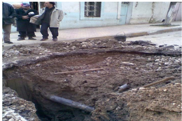
Photos N°46, N°47, N°48 et N°49 (Tronçon P 1-3) Des conduites déterrées et sont protection
