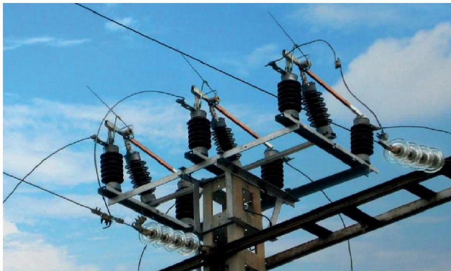
**Fig III-2** : Interrupteur aérien à commande mécanique (IACM)
