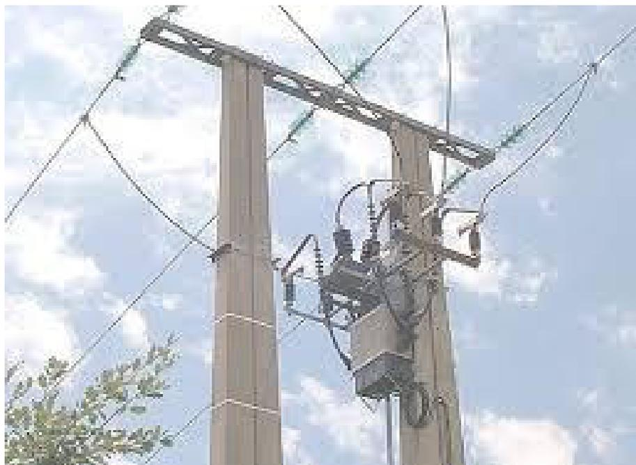
**Fig III-3** : Interrupteur aérien a creux de tension (IACT)
