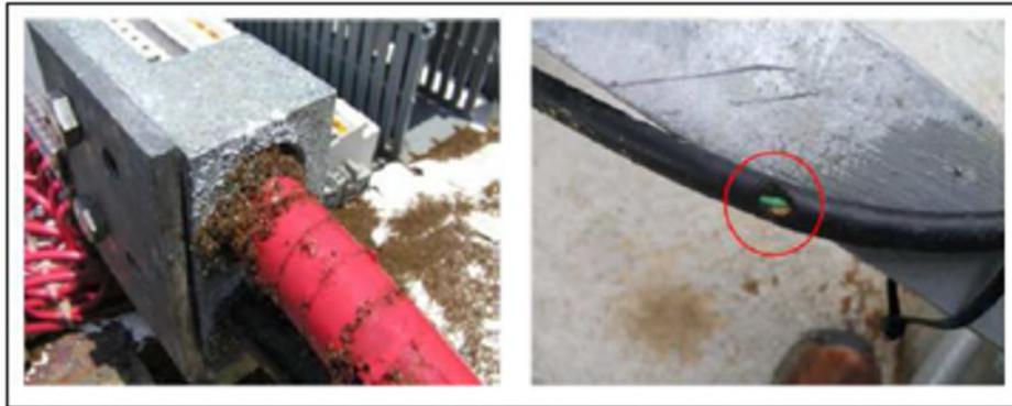
**Fig III.4** exemples de défauts rencontrés dans le câblage
