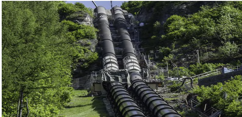
Figure (I.7) : Conduites forcées. [5]
