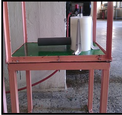
Figure II.15 : Fixation de la section de base sur la structure métallique
