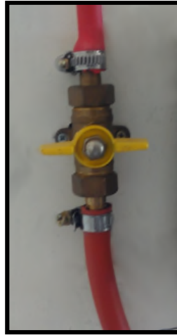
Figure II.26 : Vanne à air
