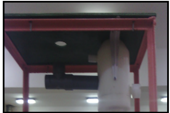
Figure II.20 : Fixation du séparateur de phases sur la structure métallique
