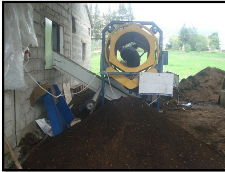
Figure 43 : Opération de criblage
