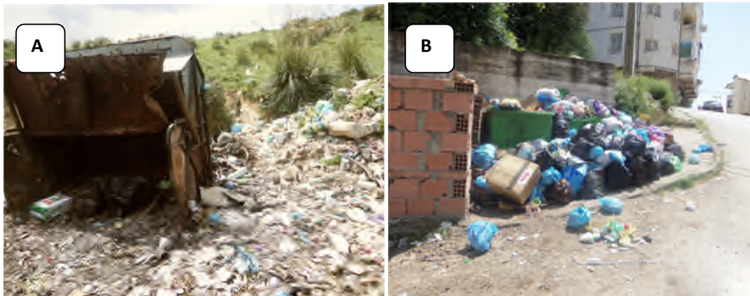
Figure N°41 : Photos montrant l'insuffisance des niche poubelle et leur état défectueux ( A : à Boulimat, B : Tala ouariane)
