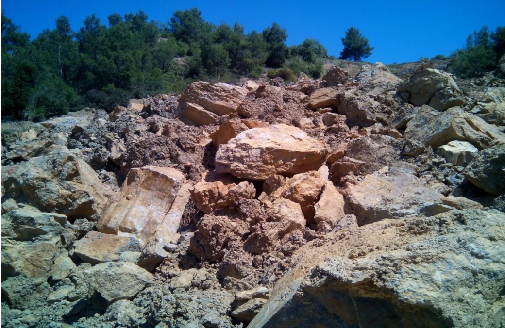
Figure 22 : Eboulis de pente, de notre site étudié à Ouendadja commune Berbacha W Bejaia.
