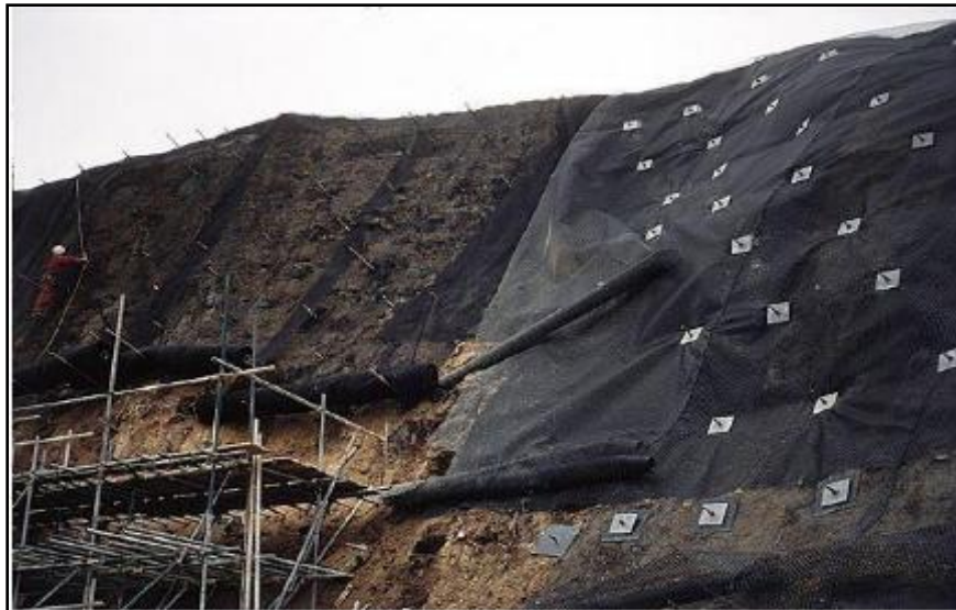
Figure 34: Un versant stabilisé par clouage [7].
