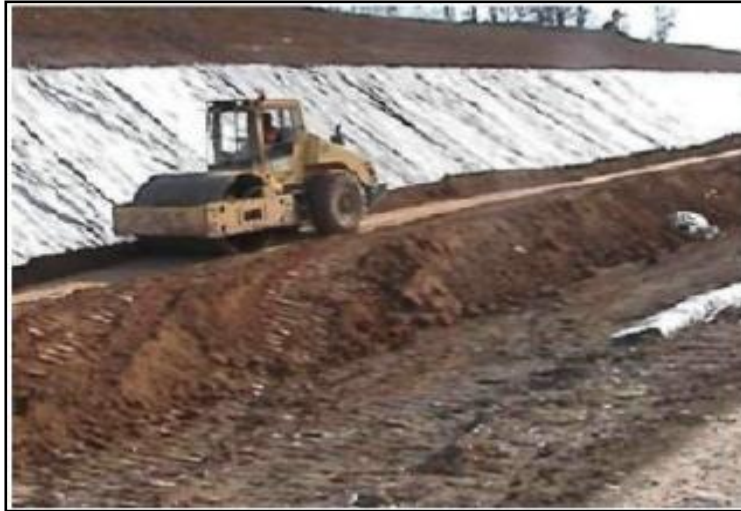
Figure 35: L'utilisation du géotextile en jouant double rôle le drainage et le renforcement du talus
