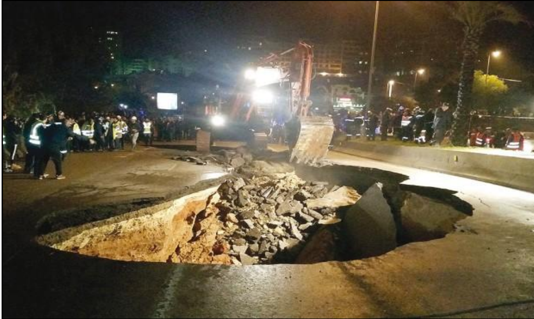
Figure 4 : Effondrement des cavités souterraines [4]
