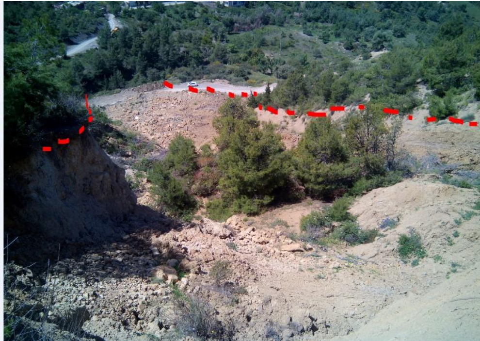
Figure 19 : Vue d'ensemble du site du glissement.
