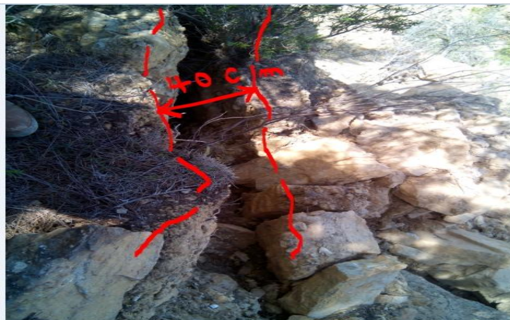
Figure 17 : Fissures longitudinales
