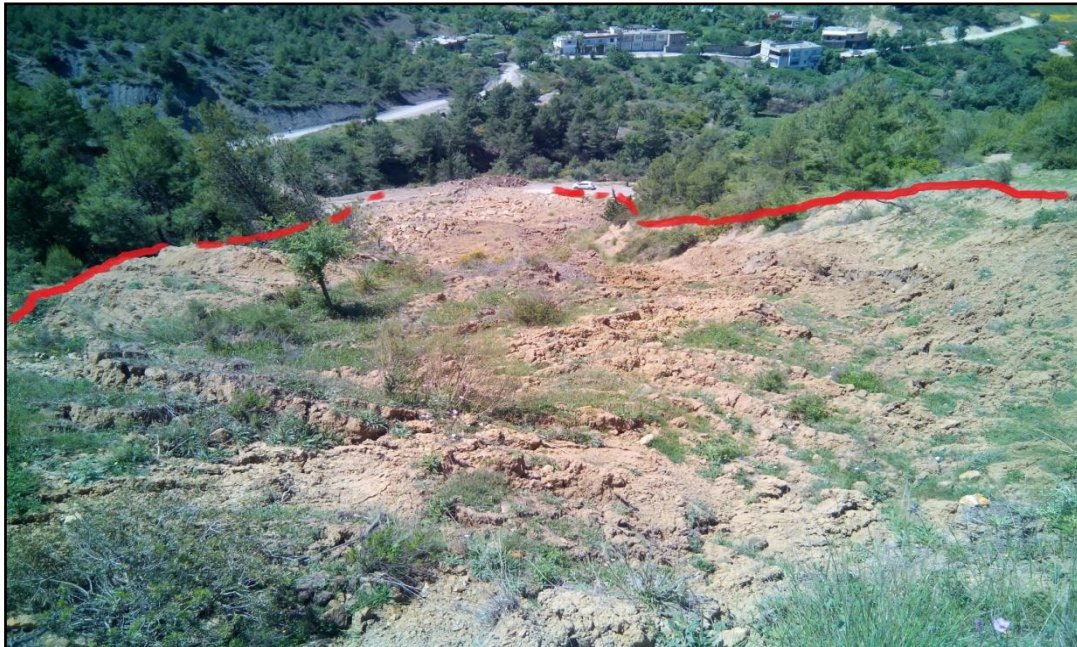
Figure 7: Glissements de terrain, de notre site étudié à Ouendadja commune Berbacha wilaya de Bejaia.
