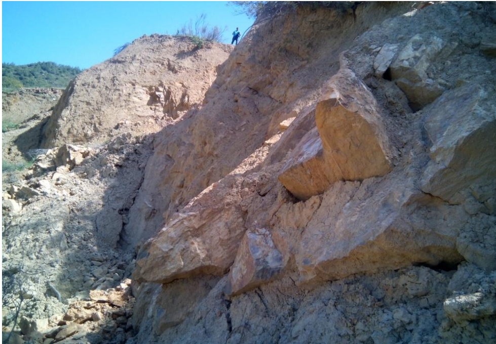
Figure 20 : Rupture du talus
