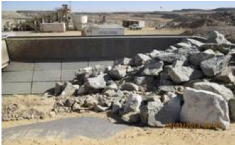
Figure II.11 : Alimentation du concasseur
