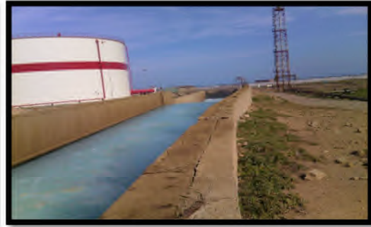
Figure IV.7: Canal de rejet.
