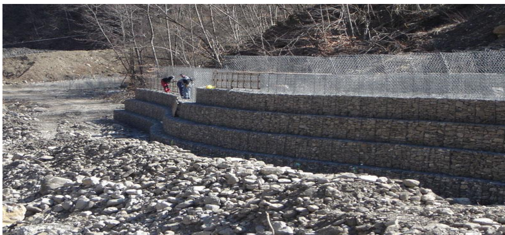
Figure I-18 : Réalisation d'un mur en gabion. [19]
