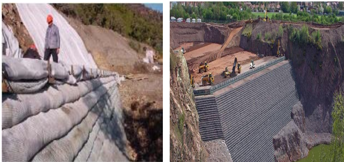
Figure I-19-19' : Chantier en cours de réalisation utilisant la technique géotextile. [18]
