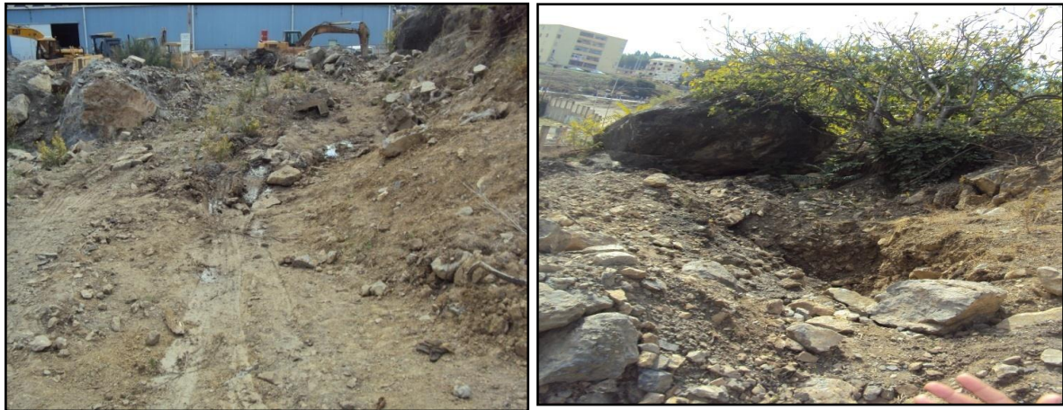
Figure II-8-8' : Travaux de terrassement au niveau du bas de talus.
