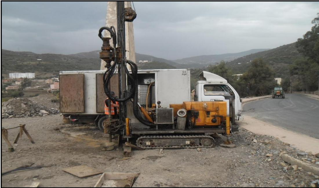
**Figure II.1:** Réalisation d'un point de sondage carotté.
