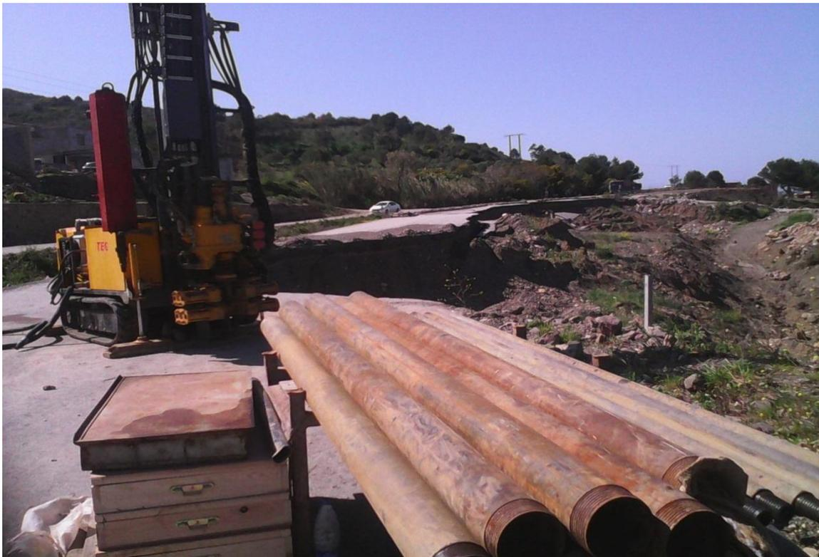
**Figure III.5 :** Implantation d'un point de sondage carottés.
