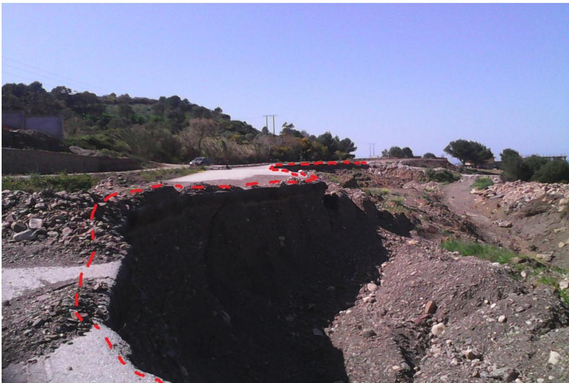
**Figure III.4 :** Vue de rupture de la chaussée.
