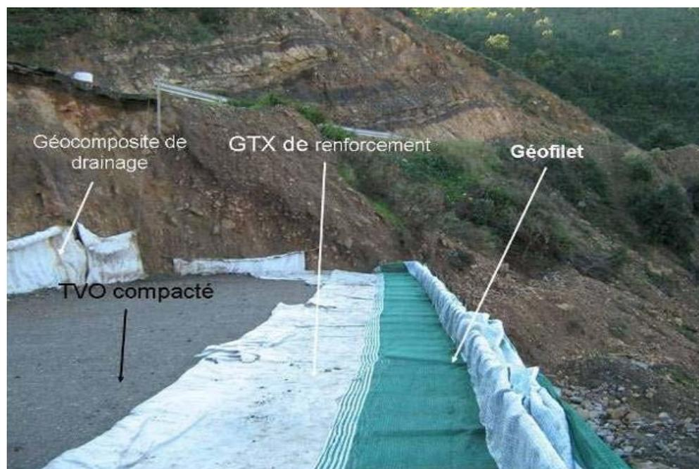
**Figure I.14** : Vue de l'ouvrage pendant la phase de travaux, désignant un exemple des géosynthétiques utilisés pour le massif de renforcement.(ARAB R et *al.*, 2009 )
