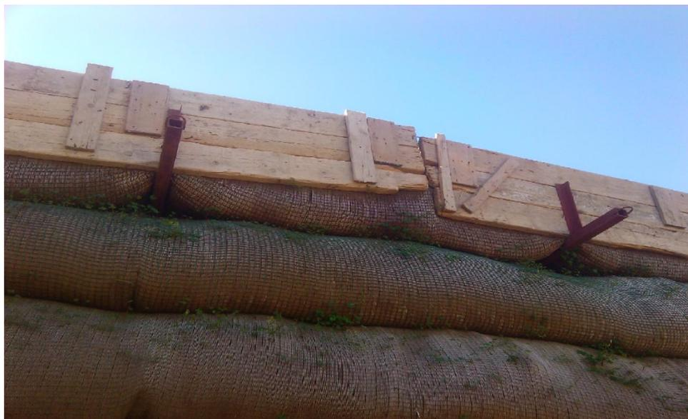
**Figure I.12** : Vue d'un mur en géotextile à RN24 SAKET (Bejaia) par le procédé du coffrage amovible.
