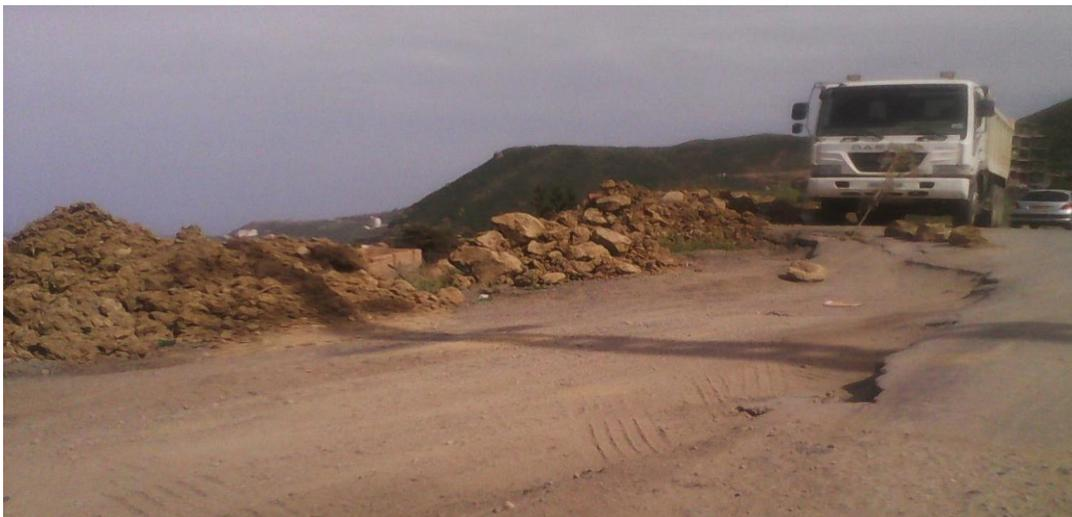
**Figure II.12 :** Conséquence des remblais de pieds sur la stabilité de la RN 24 au PK 235+500 (LAACH LBAZ).
