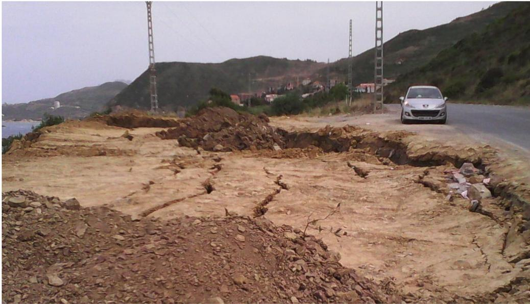
**Figure II.9 :** Vue d'un exemple d'activité humaine à Tala Ilef PK 235+300, conséquence, d'un glissement de terrain.
