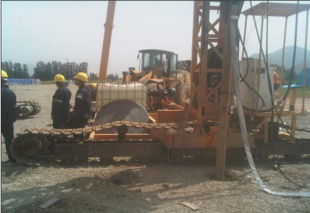
**Figure I-14 :** Vue de la mise en œuvre des drains verticaux. [Photo chantier, 2015].
