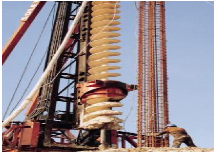
Figure.III.1. forage des pieux
