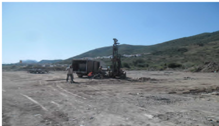
Figure II. 3: sondage carotté réalisé sur le site.
