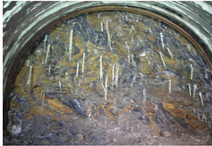
Figure II.5: Exemple de Creusement en pleine section.
