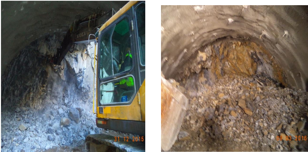
Figure II.8: l'étape de purge et marinage (projet de kherrata).
