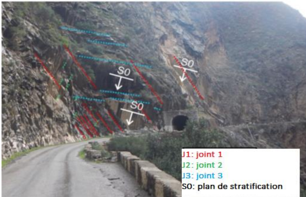
Figure IV.2: Vue de portail Nord avec les principales familles de discontinuités.
