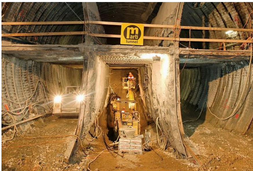
Figure II.7: Exemple Creusement en sections divisées. [15]
