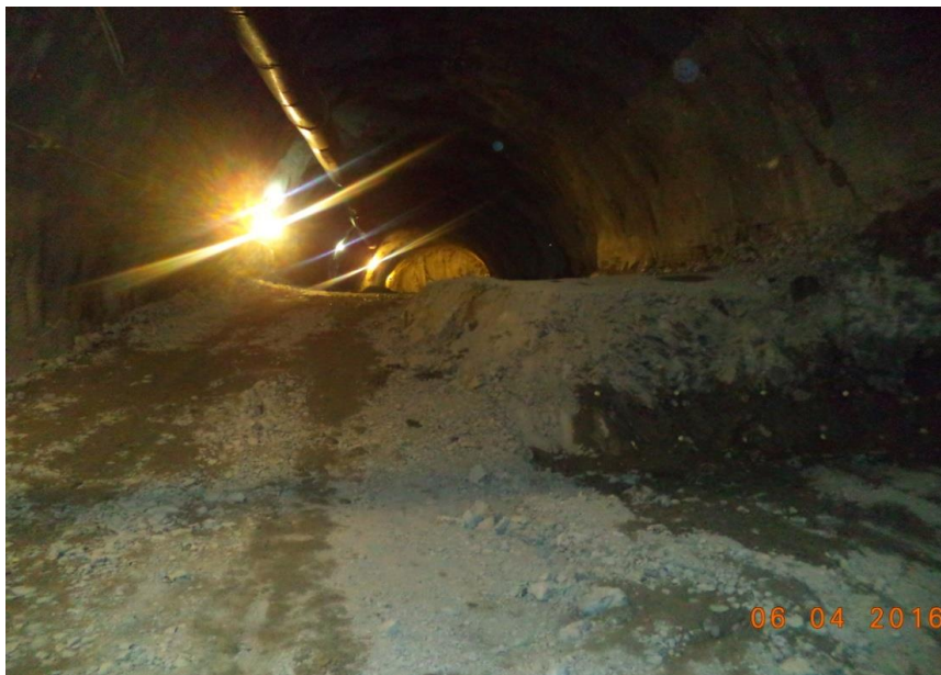
Figure II.6: Creusement par demi-section supérieure (calotte & stross), [projet de kherrata].
