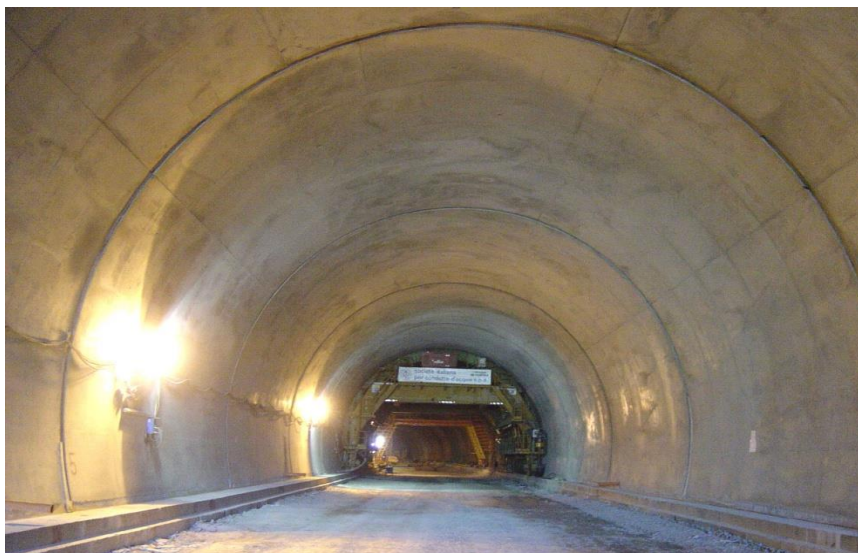
Figure II.19: pose du Revêtement définitif. [15]
