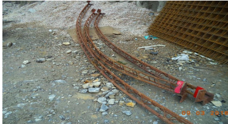
Figure II.16: les cintres métalliques légers (projet de kherrata).
