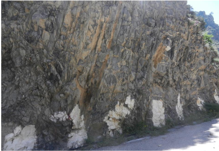
Figure III.5: Vue de la falaise calcaire grande degré de fracturation. Proximité d'une faille sur la RN-9 actuelle au niveau du Pk 6+500 du projet.
