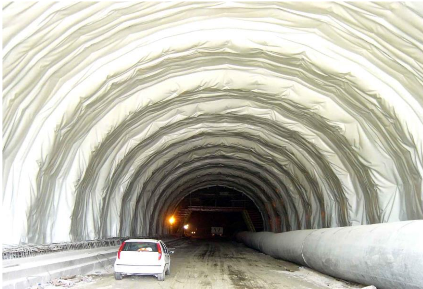
Figure II.18: Pose de l'étanchéité. [15]
