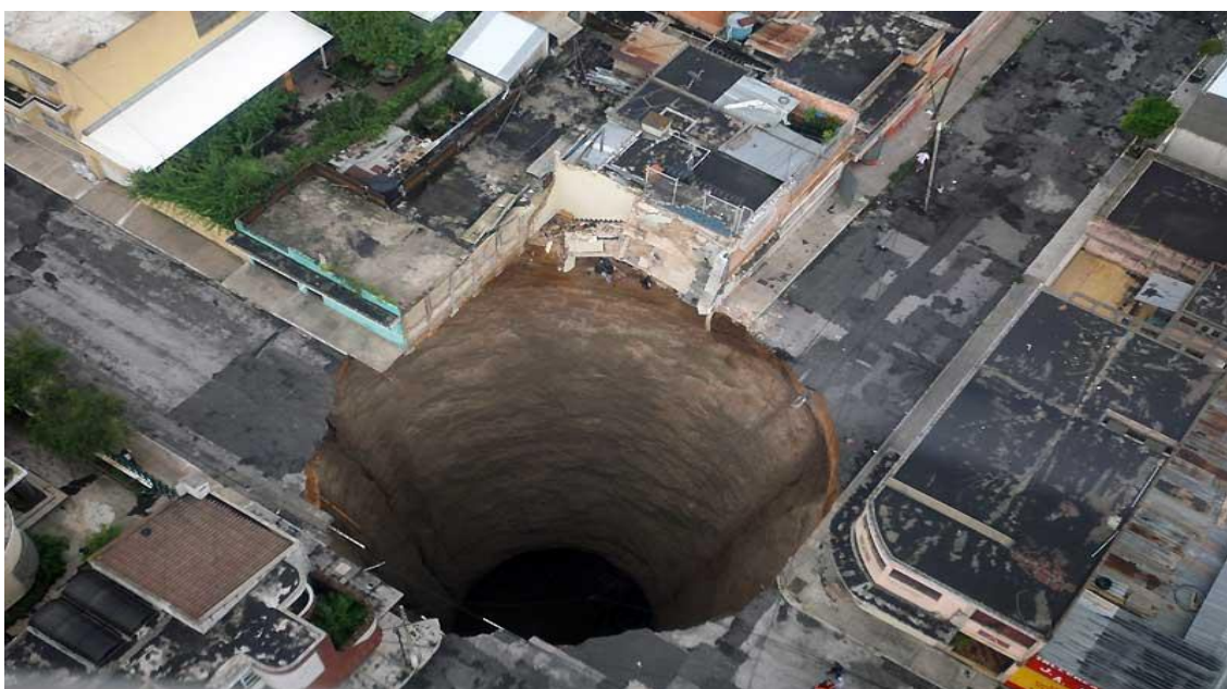
Figure I.8: Effondrement des toits des cavités souterraines à Guatemala [4]
