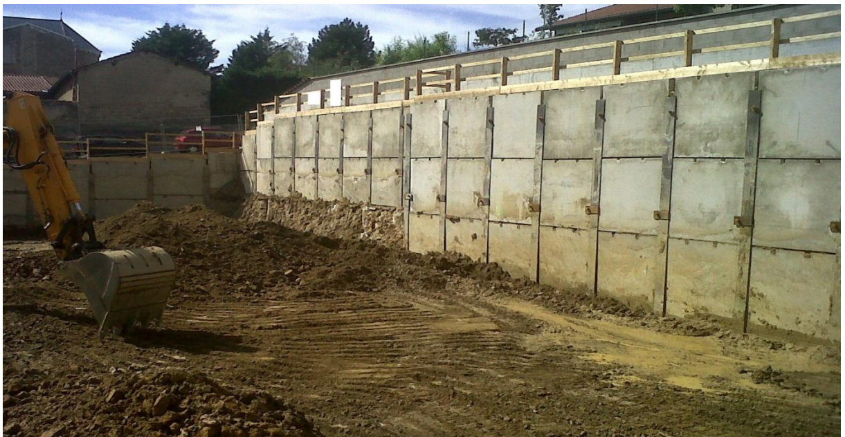
Figure II.10: Paroi berlinoise provisoire et définitive [13]
