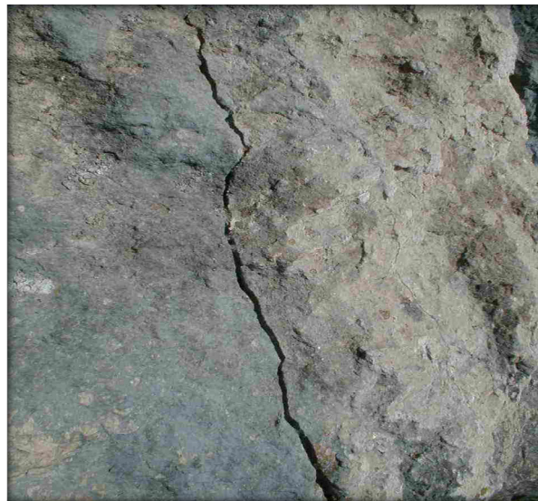
Figure II.3 : Exemple d'une fissure.
