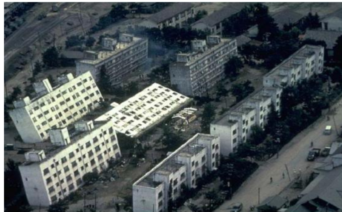
Figure N°20 : Inclinaison des bâtiments d'appartements de Kawagishi-cho à Niigata au Japon dues à la chute de la capacité portante du sol par liquéfaction (d'après Peter M. Byrne et al, 2008). [23]
