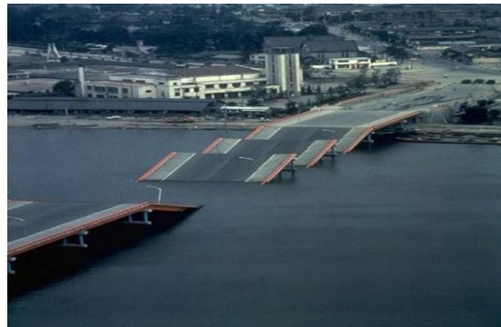
Figure N°21 : Rupture du pont de Showa, à Niigata au Japon, dues à l'épandage latéral dans le sol (d'après Peter M. Byrne et al, 2008)[23]
