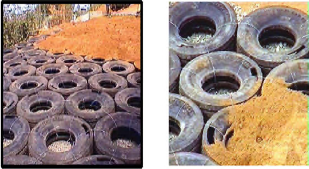
Figure III.14 : Attache et remblaiement de la ieme couche des pneus (Y.HAMMADI)
