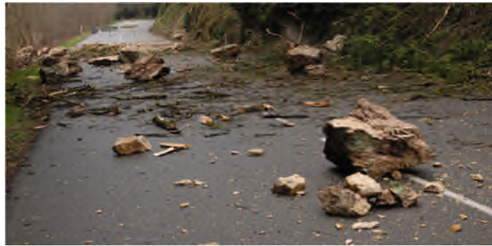
Figure I.6 : chute de blocs et de pierres.
