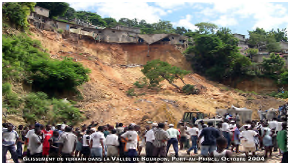
Figure II.1. Construction au sommet de talus la Vallée de Bourdon 2004 (R.Internet)
