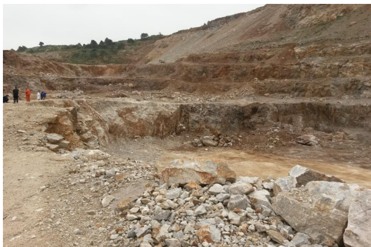
Photo.04. Photo d'une plate forme de tir lors de l'opération de chargement à adraroufarnou
