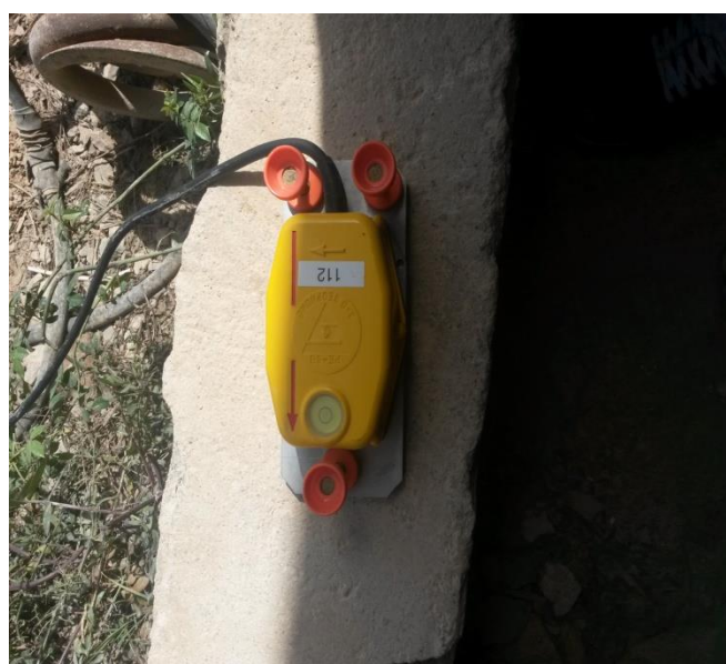
Photo.08.Emplacement de capteur sismique sur une plate forme
