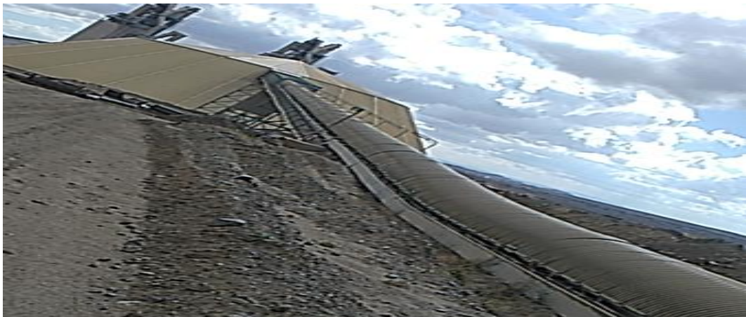
Figure I. 8. Hall de pré homogénéisation (Hammam d'alaa) [2].
