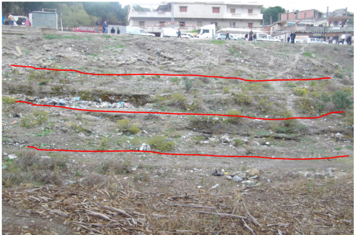
Figure I-6.c : Structure en gradin [16].
