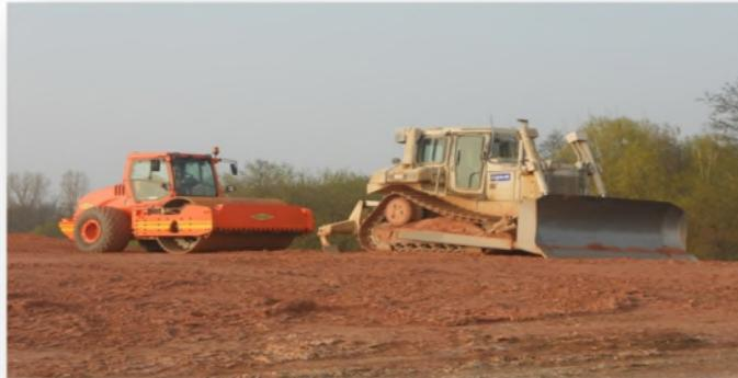
**Figure II.1.**Utilisation des boues de dragage dans les remblais routiers
