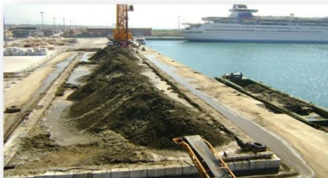
**Figure II.3 :** Utilisation des boues de dragage dans la fabrication du sable
