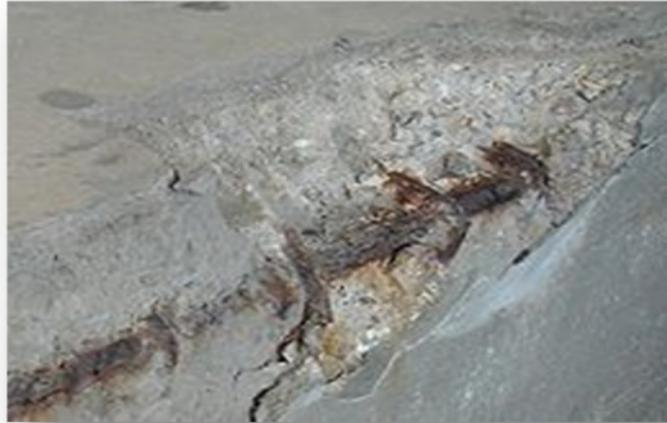
**Figure II.2 :** Carbonatation du béton.
