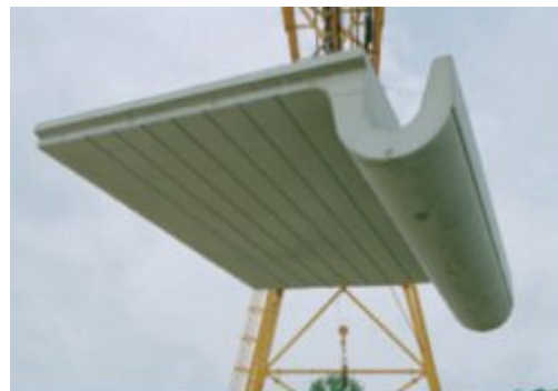
Application du BAP dans la préfabrication
