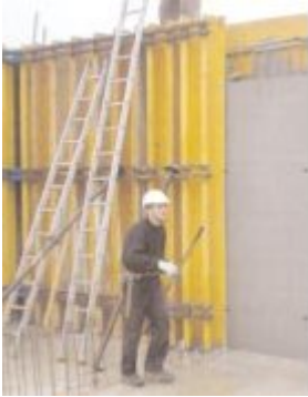
Coffrages panneaux avec poutrelles ( h \leq 3 m)
