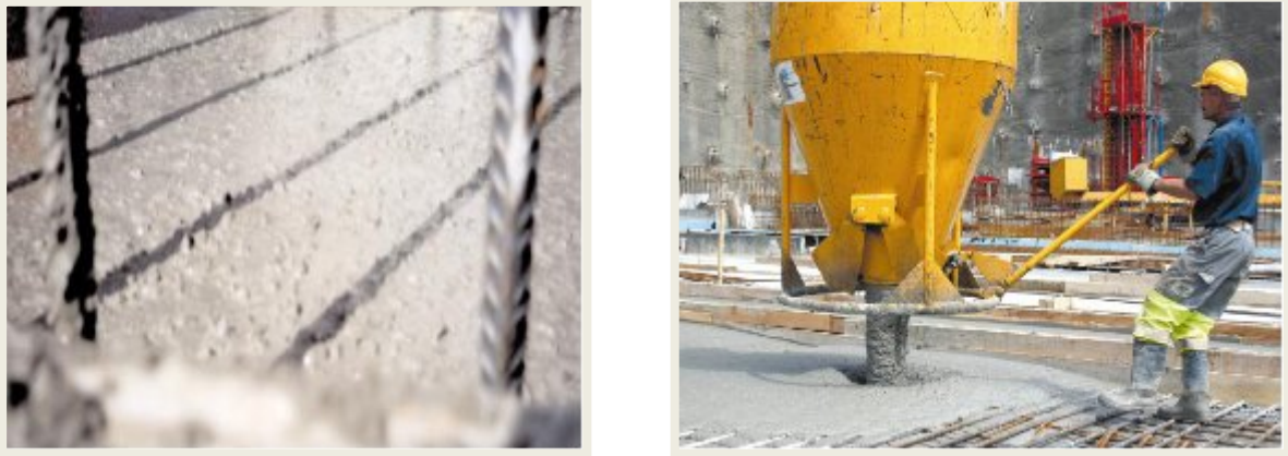
Figure 2 : les granulats nagent à la surface sans aucune ségrégation.[24]
