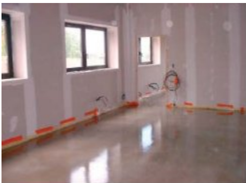
Application du BAP dans les planchers
