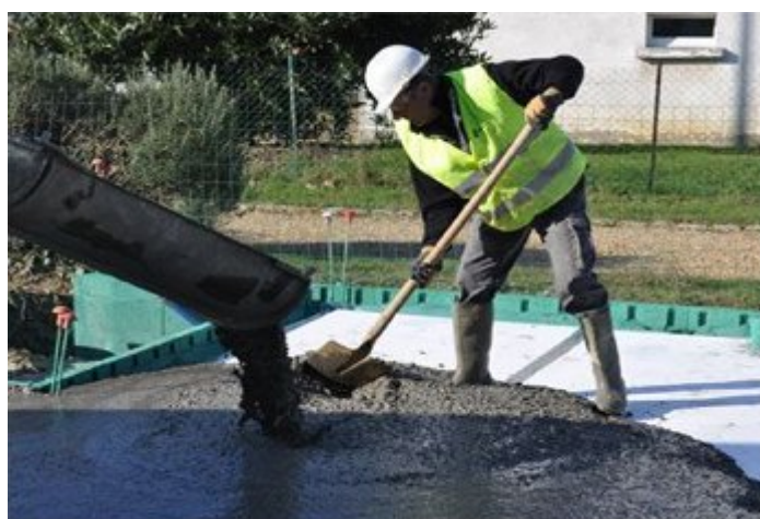
Figure 16 : Mise en place aisée du BAP par un seul ouvrier
